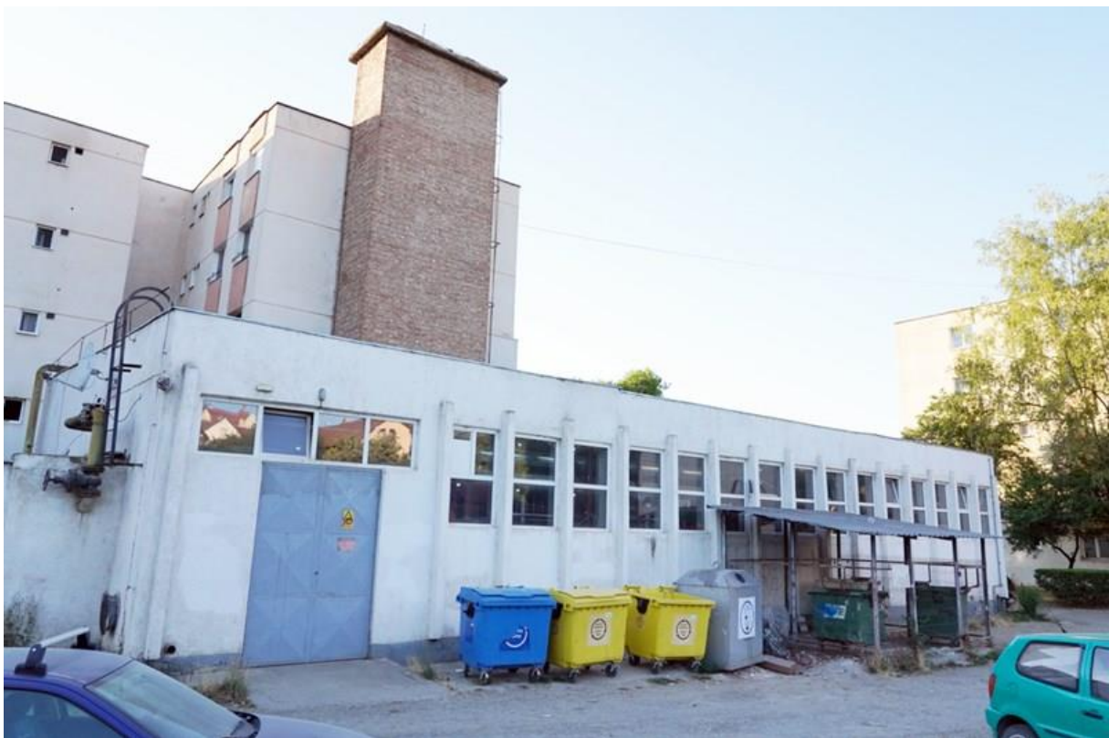
Clădirea centralei termice din cartierul Insulei.
